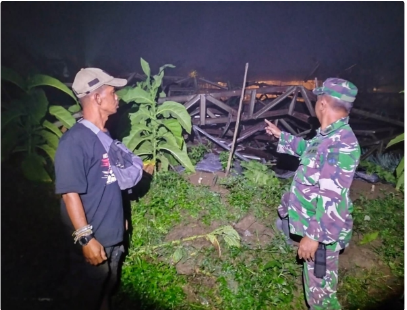
Pelda Budi Furi, anggota Koramil 04/Windusari mengecek rumah warga yang mengalami kerusakan akibat hujan disertai angin kencang
